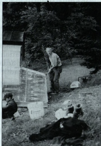
Il nostro Ugo durante la sistemazione del tetto della segrestia di Iore, coadiuvato da Nicola. Agosto 2004.
